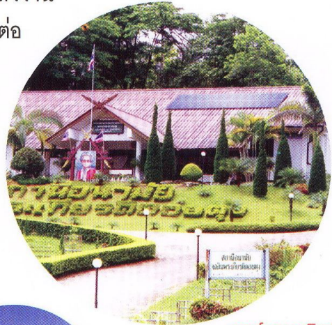
เซลล์แสงอาทิตย์บนหลังคาสถานีอนามัยเฉลิมพระเกียรติดอยตุง
