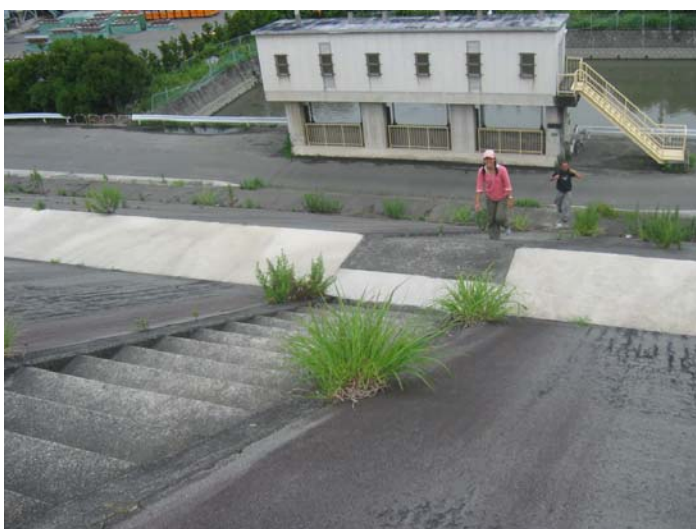
รูป 6.12 กำแพงสูงสร้างไว้เพื่อกั้นสึนามิ บริเวณเมืองชิซูโอกะ
