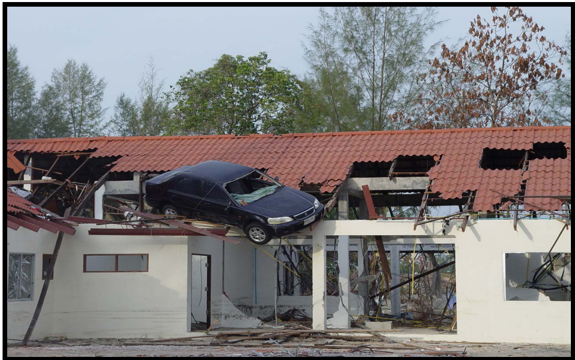
รูป 3.22 ผลจากการที่วัตถุเกิดการลอยและถูกลากจูงเนื่องจากคลื่นสูงปะทะฝั่งและเคลื่อนถอยกลับจนทำให้รถลอยน้ำและเมื่อน้ำลดรถจึงเกาะติดไว้กับโครงสร้างชายฝั่งที่มนุษย์สร้างขึ้น (ภาพโดยภาควิชาธรณีวิทยา คณะวิทยาศาสตร์ จุฬาลงกรณ์มหาวิทยาลัย)
