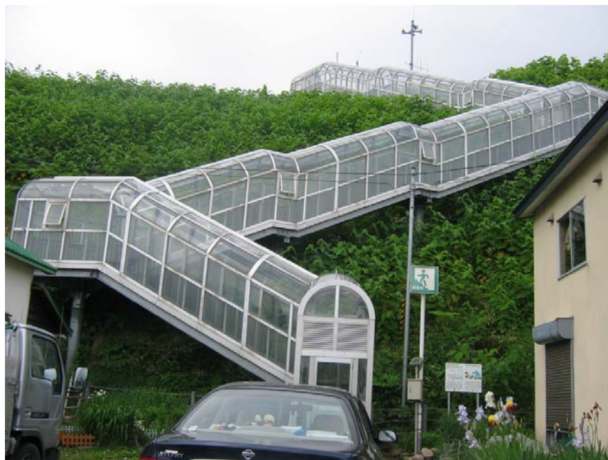
รูป 6.14 บันไดสำหรับหนีภัยสึนามิหรือพิบัติภัยอื่นๆ เช่น ลมพายุ ที่อาจเกิดขึ้นบริเวณชายหาดที่มีหน้าผาชันที่เมืองฮิโร (Hiroo)
