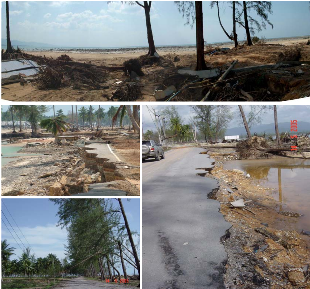
รูป 4.61 ภาพบันทึกจากการสำรวจภาคสนามแสดงสภาพความเสียหายจากการกัดเซาะชายฝั่งอันเป็นผลเนื่องมาจากสึนามิบริเวณแหลมปะการัง (ภาพบนสุดถ่ายไปทางทิศตะวันตก เมื่อวันที่ 7 มกราคม 2548) ภาพกลางและล่างบันทึกเมื่อวันที่ 14 พฤษภาคม 2548 แสดงการกัดเซาะอย่างต่อเนื่องจากมรสุม
