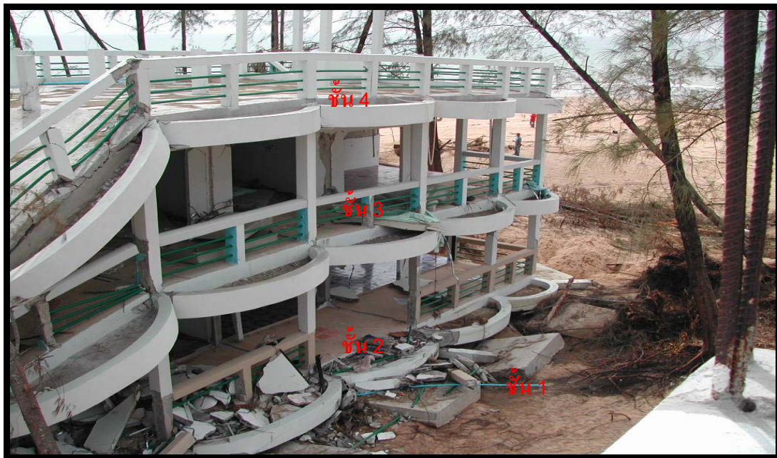
รูป 3.24 การแตกหักพังและยุบตัวของอาคาร บริเวณบ้านบ้านคึกคัก ต.คึกคัก อ.ตะกั่วป่า จ.พังงา ในรูปแสดงการยุบตัวของอาคารชั้น 1 จนทำให้ชั้น 2 พังลงมา อันเป็นผลมาจากพลังการทำลายของสึนามิ
